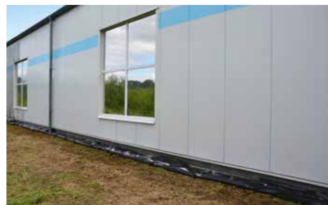
Nach einer Fassadenreinigung durch wir-reinigen-fassaden wird das Gebäude zum repräsentativen Vorzeigeobjekt.
